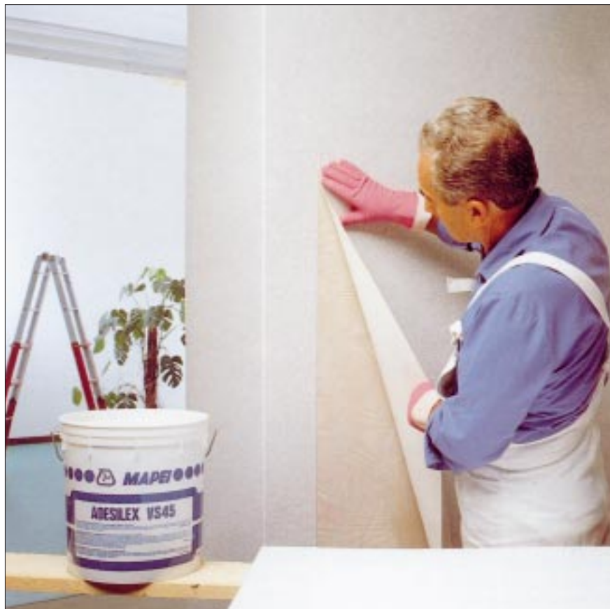
Stesura di ADESILEX VS45 con spatola n. 1
