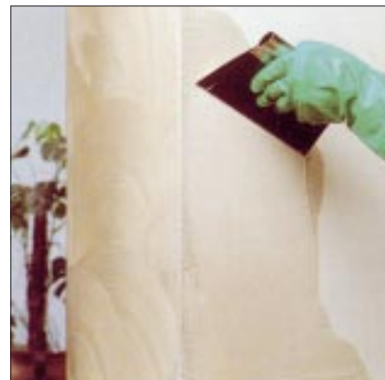
Stesura di ADESILEX VS45 con spatola n. 1
